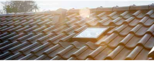
Instalação discreta e estética no seu telhado, ficando ao nível das telhas
